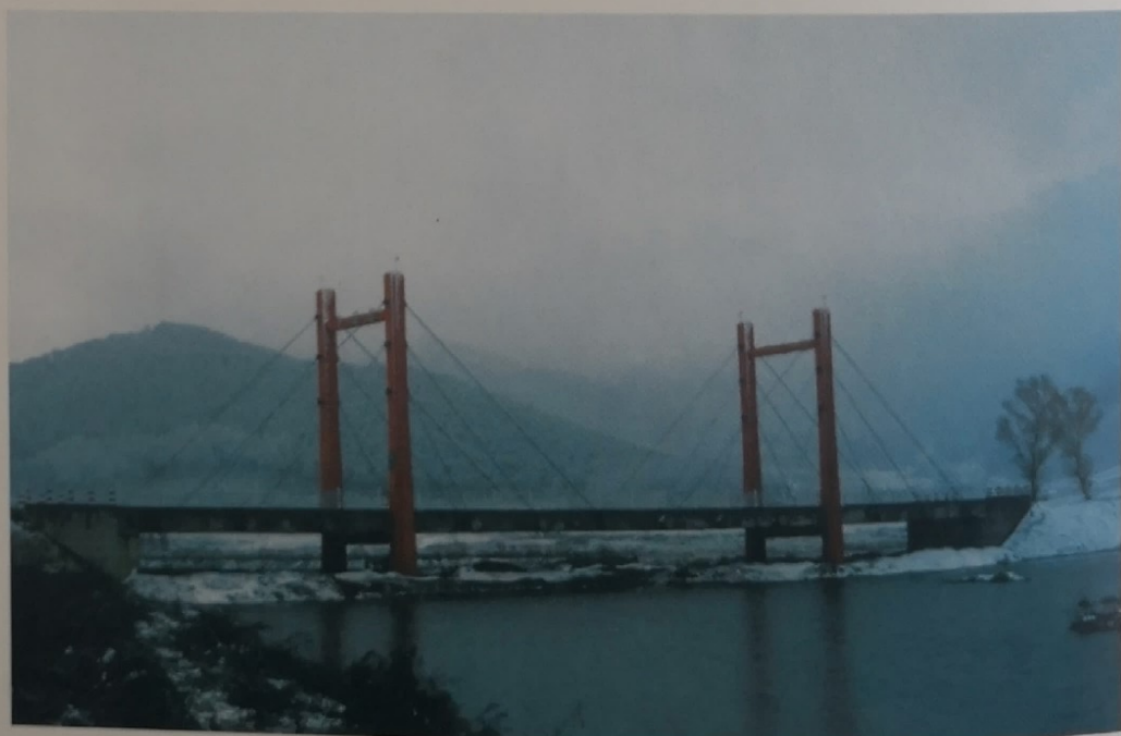
东丰县龙头水库斜拉桥
